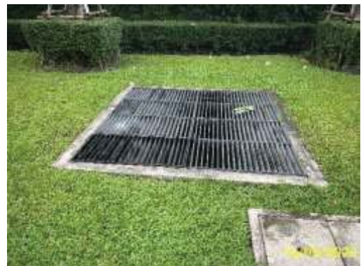
บ่อพักน้ำ (Manhole)
